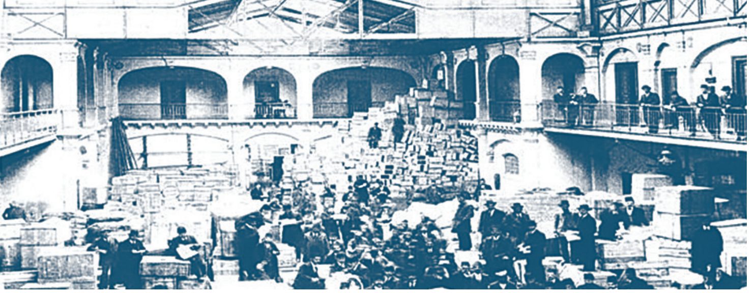
Galata Dahili ve Ecnabi Malları Gümrük Binası (19. yy)
