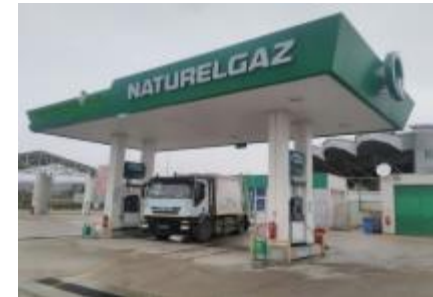
Bolu NG Oto CNG İstasyonu
