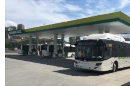
Istanbul / Alibeyköy NG Oto CNG İstasyonu
