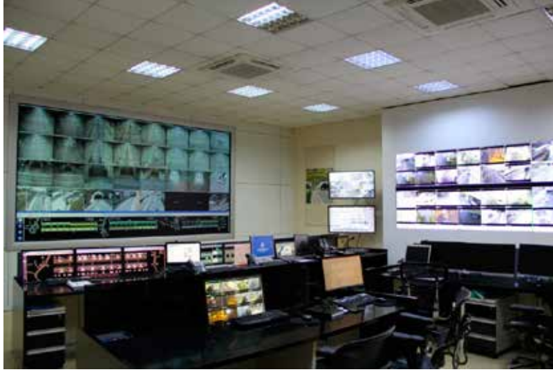
Şekil 4.37: Tünel İşletim Merkezi, 2013
