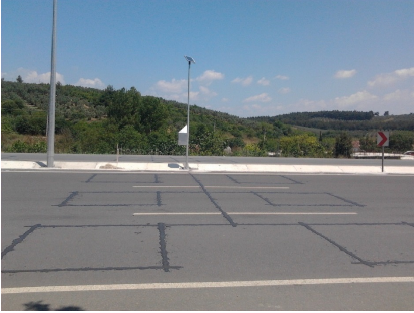
Şekil 3.1.1. Manyetik Döngülü Otomatik Trafik Sayım Sistemi
